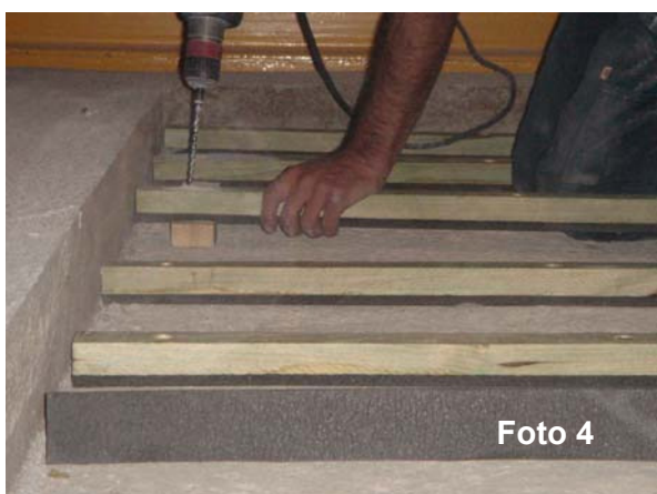
Fotos 3-5: Montaje de rastreles sobre calces
