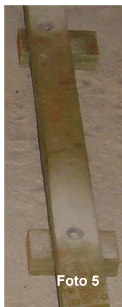
Fotos 3-5: Montaje de rastreles sobre calces
