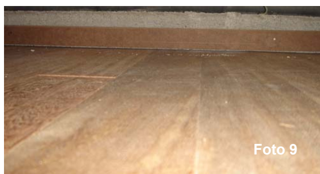
Fotos 6-9: Montaje de lana de roca, tarima y rodapié
